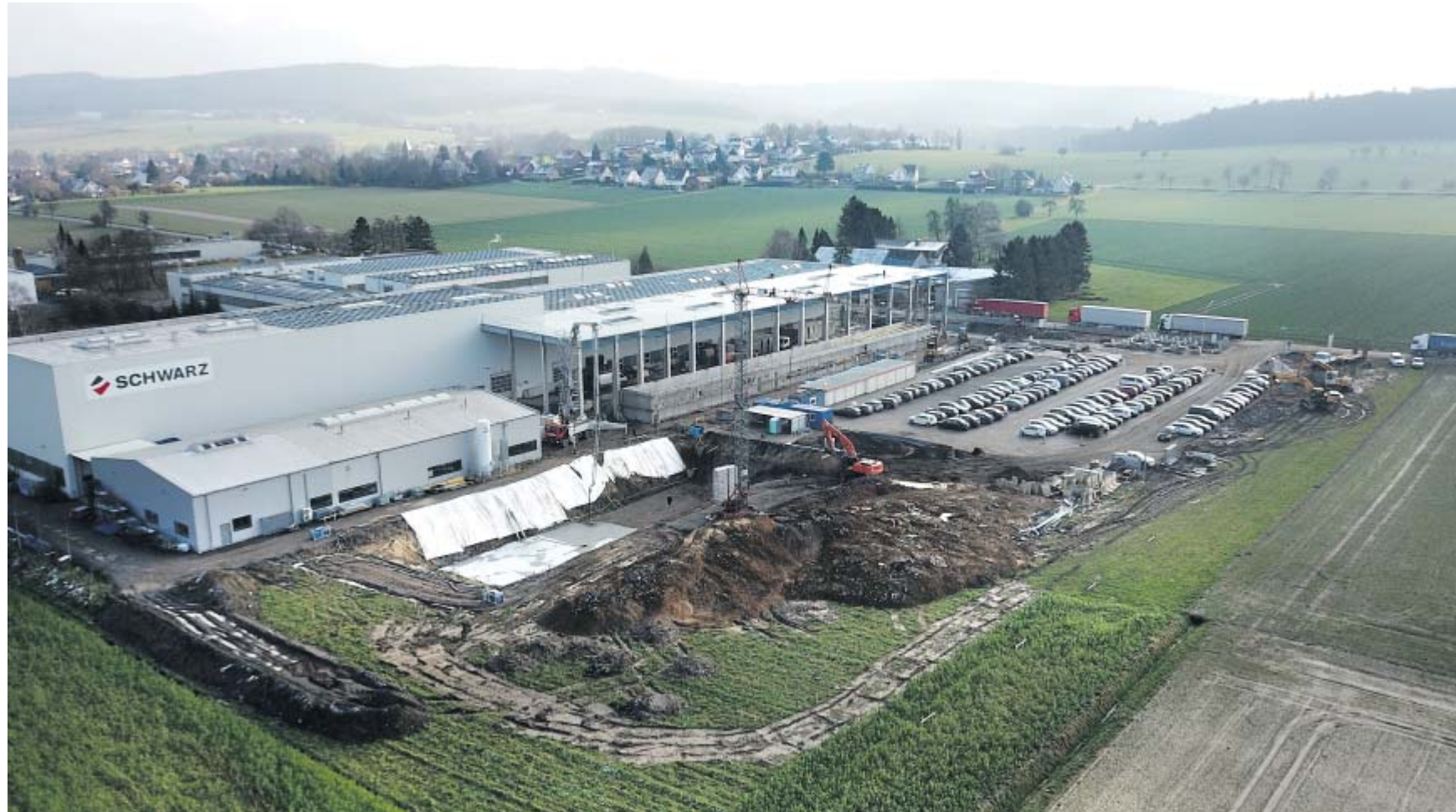
Aus der Vogelperspektive: Die Bauarbeiten im Gewerbegebiet „Hammerland“ sind gut zu sehen.
