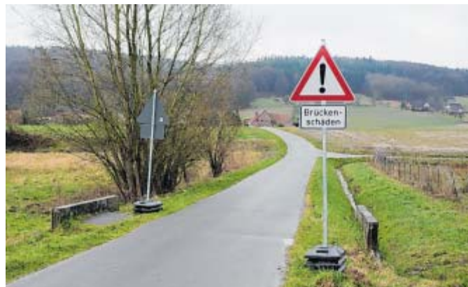
Freigegeben : Die Brücke am „Großen Teichweg“ im Bereich Eickwiesen kann von Fußgänger und Autos überquert werden.
