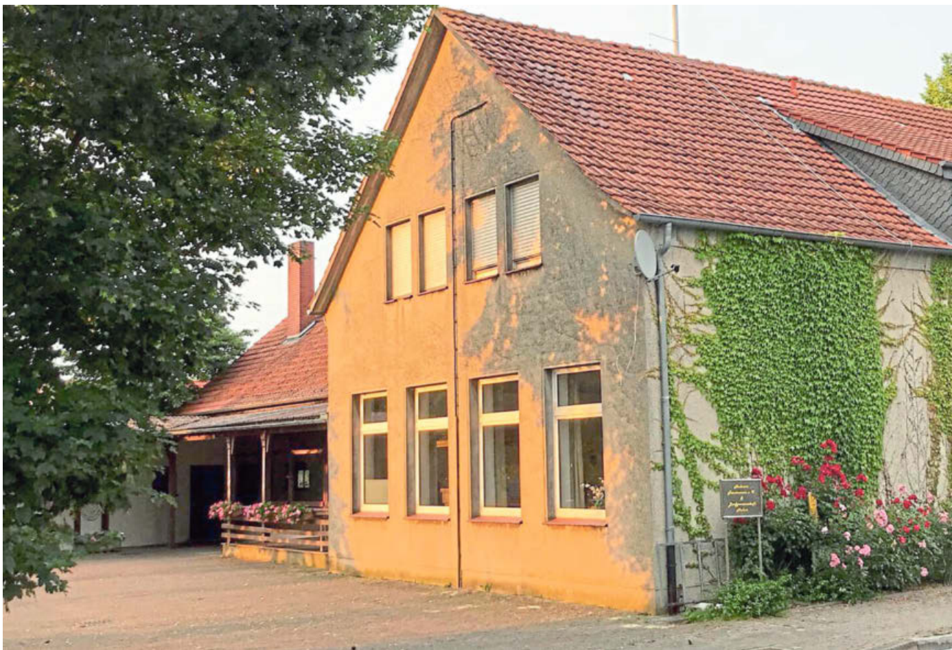
Alte Schule in Hedem: Hier müssen der Keller, die Fenster und die Heizung saniert werden.
